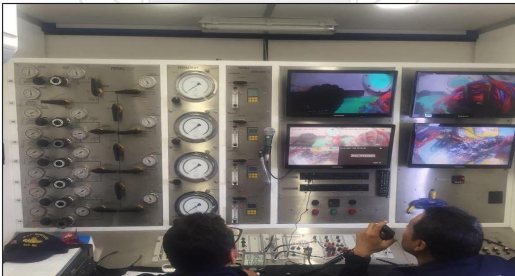
**Figura 4. Consola de buceo de mezcla de gases, B.A.P. Morales RAS-180.**
